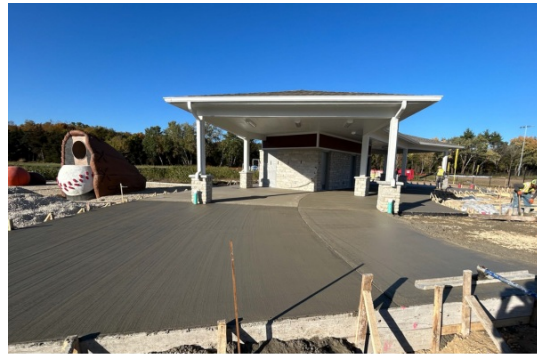
Concrete pour progress
